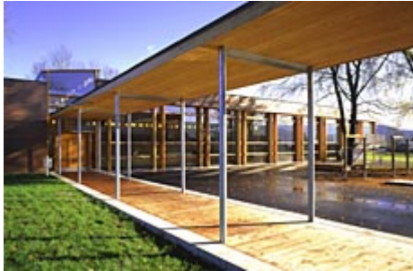
Sporthalle bei der Atrium-Schule
